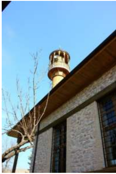
Şekil 24: Subaşı Camii batı cephesi ve minaresi. (M.Şamil ÖZYURT – 2018)
